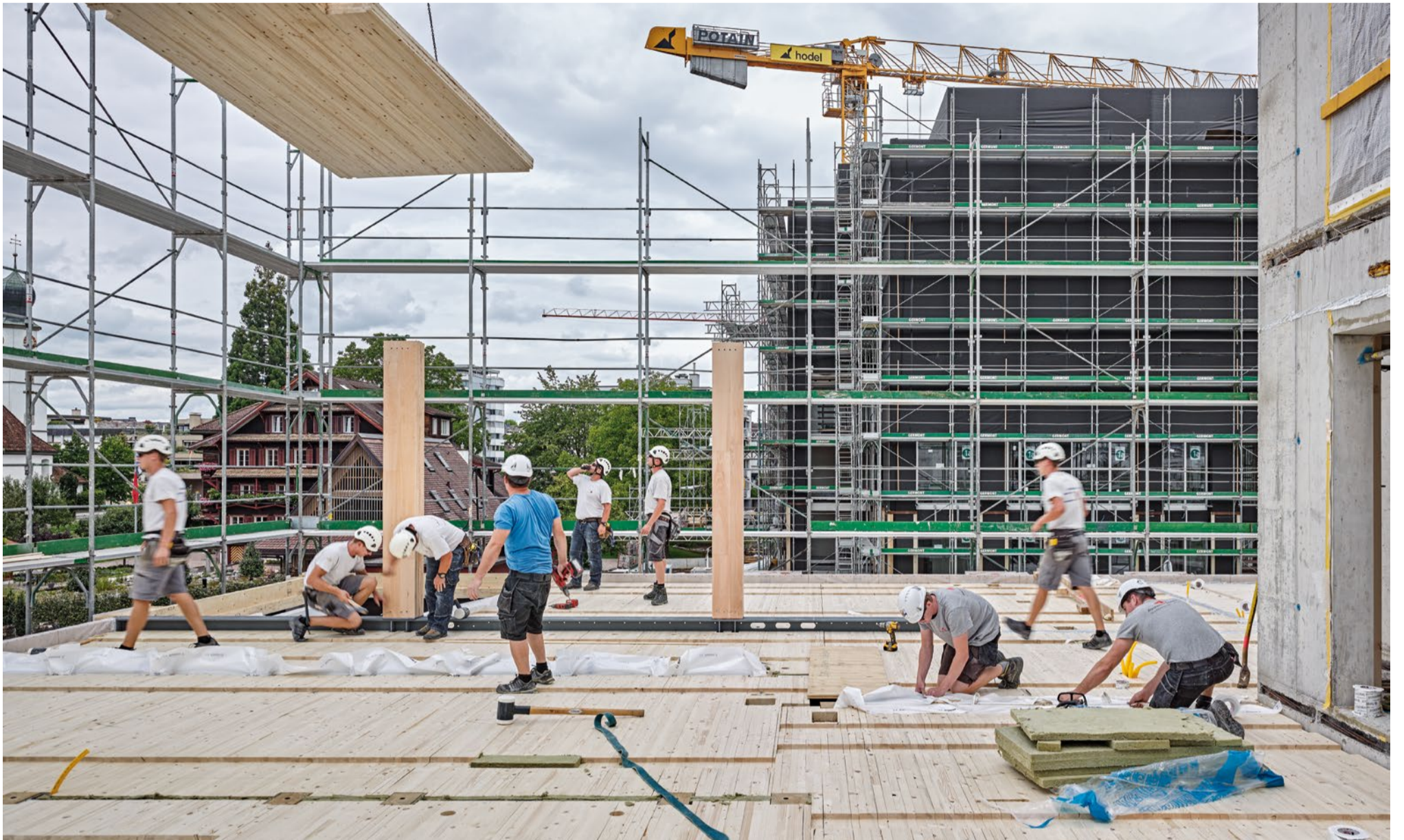
Beim Projekt Oele wurde die optimale Durchlaufwirkung von Holz-Beton-Verbunddecken gezielt genutzt.
