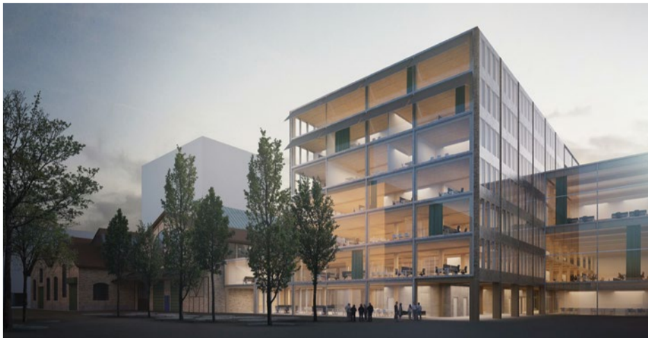
Das neue Bürohaus Elefant integriert sich harmonisch in die bestehende Industriearchitektur ...
